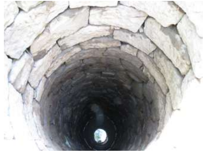
石組井戸の内部
